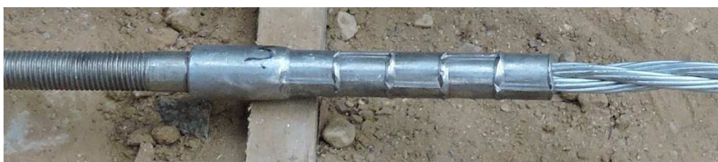
Рисунок 4. Опрессовка концевой втулки.
