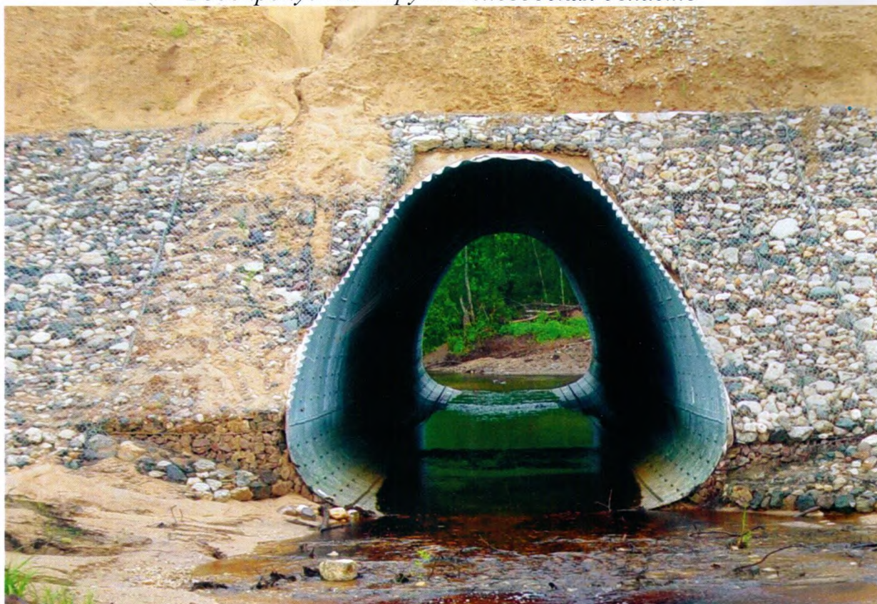
Смоленская область водопрпускная труба через приток р. Воль
