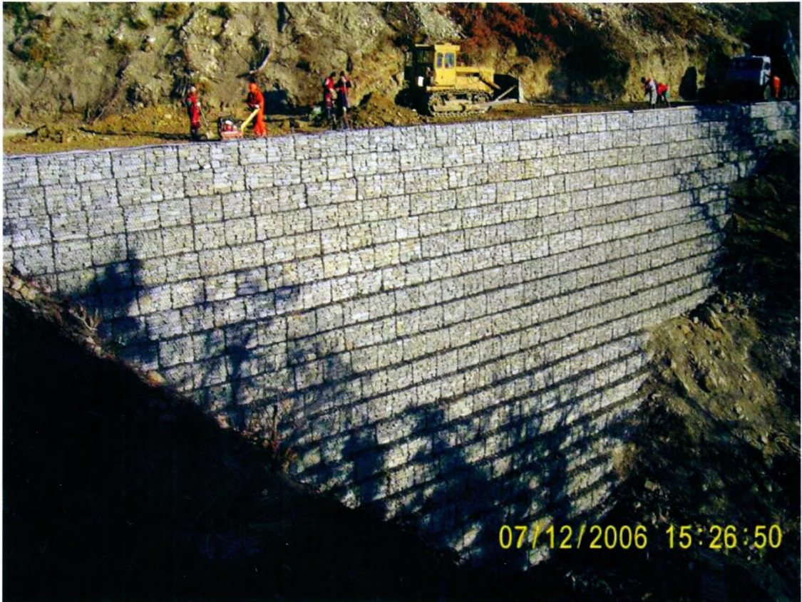
Подпорная стенка на подходе к путепроводу автодороги М-4 «Дон»
